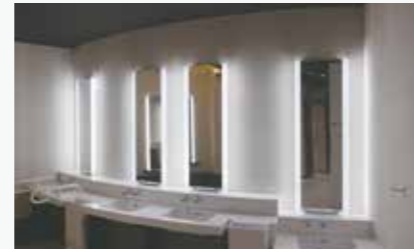
施工場所：成田国際空港 第1ターミナル 南ウイング4階出発ロビートイレ
