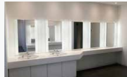
施工場所：御幣島ビル
